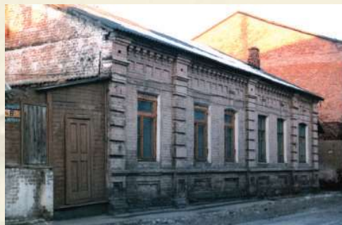
г. Витебск, ул. Покровская (ранее – ул. Дзержинского), 6 (1967–1995)
