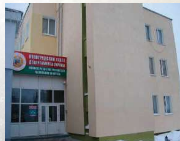
г. Новогрудок, ул. Садовая, 5а
