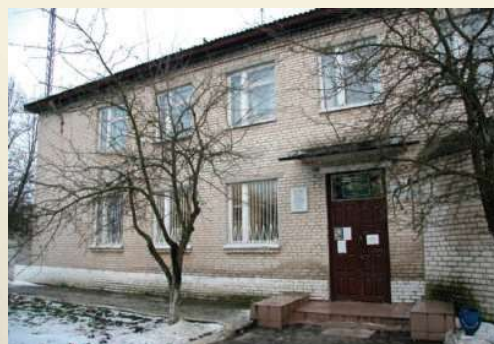
г. Мосты. Старое здание отделения
